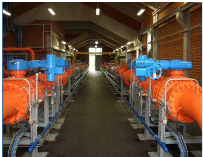
Abbildung 4-3: Live-Überwachung der Kraftwerke und der Netze bei den Stadtwerken München, Gasdruckregelanlage Hebertshausen der Stadtwerke München, /SWM-03 13/
