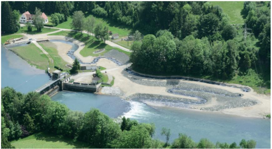
Das Projekt Flussraum Iller besteht aus fünf unterschiedlichen Bausteinen: An der Staustufe Legau sind ein Steg über die Iller, ein naturnahes Illerufer, ein neues Auengewässer, eine Fischbeobachtungsstation sowie ein Tretbecken entstanden.
